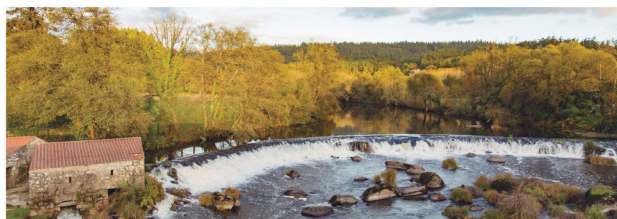
Ponte Maceira Negreira
